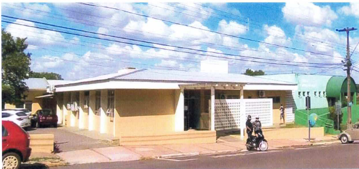
Foto VI - Fachada Centro de Saúde.
