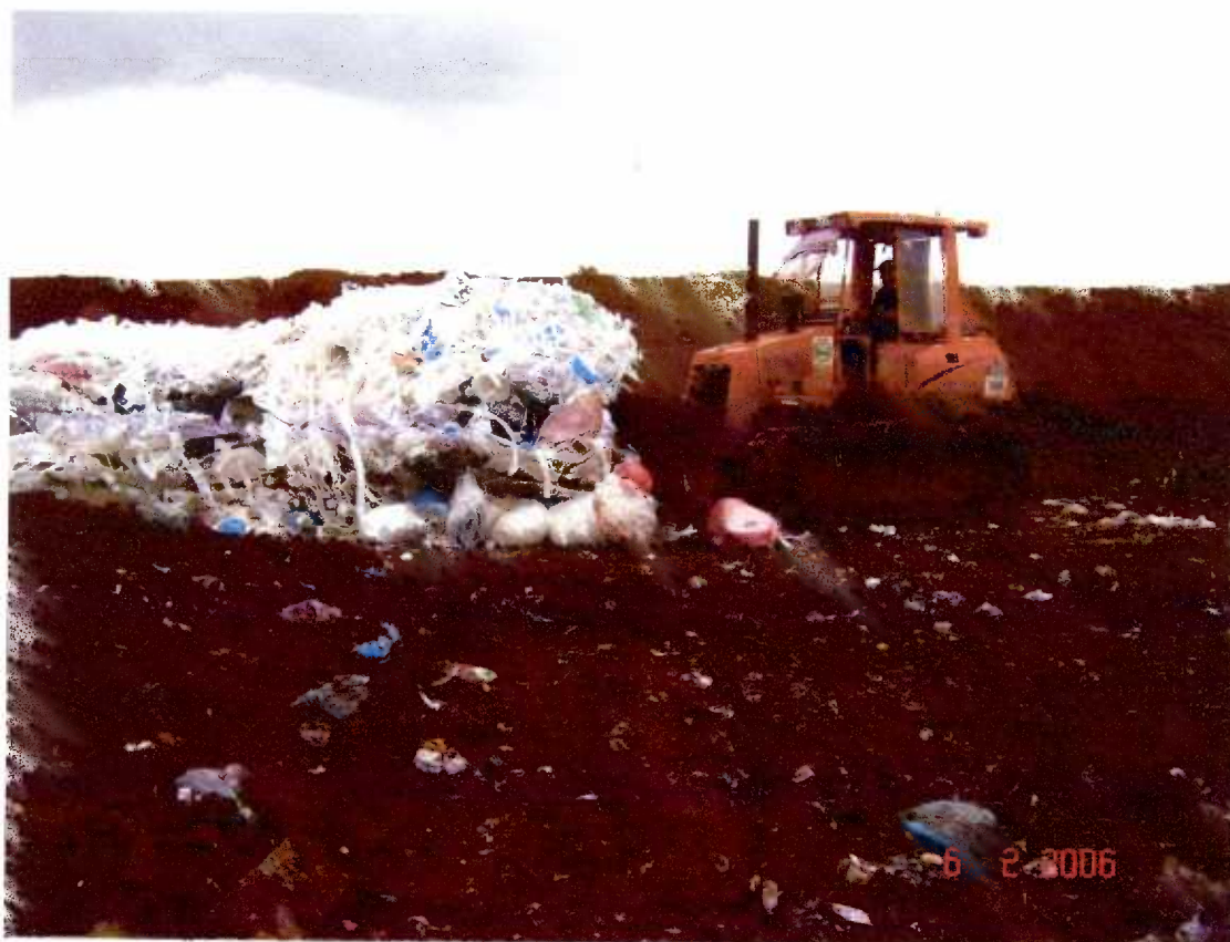
Figura 79 – Compactação dos resíduos industriais no aterro sanitário municipal de Toledo-PR.
