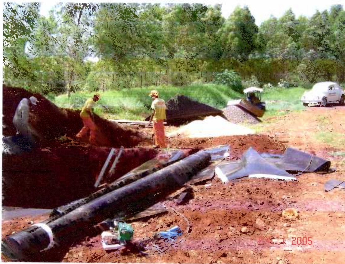
Figura 103 – Construção da vala impermeabilizada para RSS, revestida com geomembrana de PEAD 3,0mm, no aterro sanitário de Toledo-PR.
