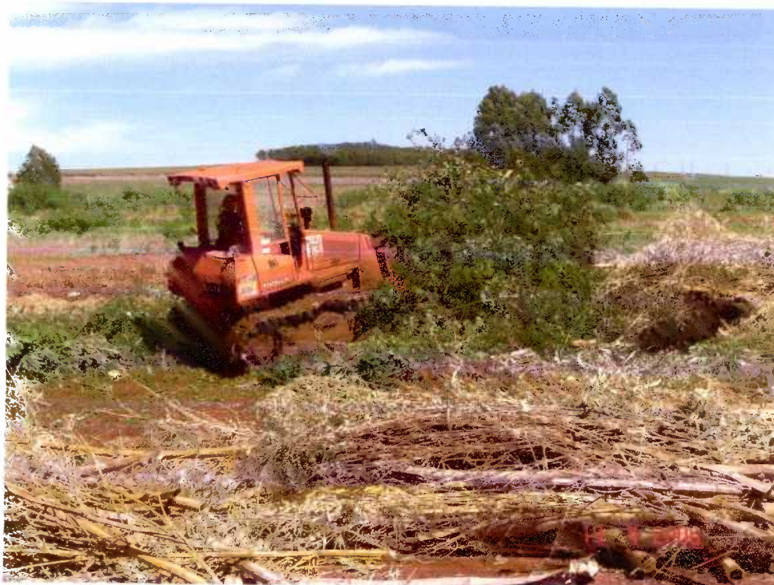
Figura 140 – Compactação dos resíduos de poda e capina no aterro sanitário municipal de Toledo-PR.
