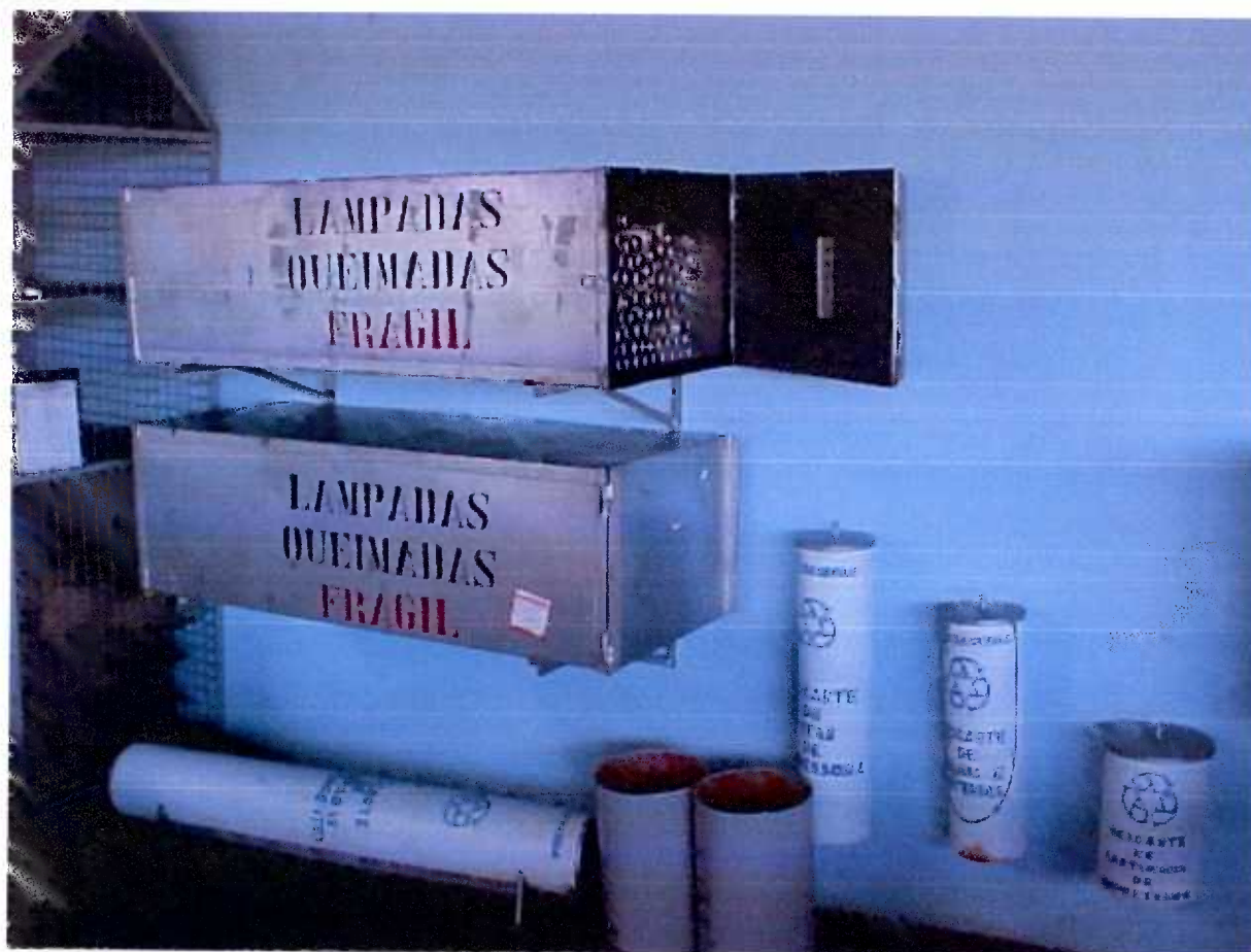
Figura 85: Ponto de armazenamento temporário de lâmpadas fluorescentes localizado na SANEPAR – Unidade Regional de Toledo.
