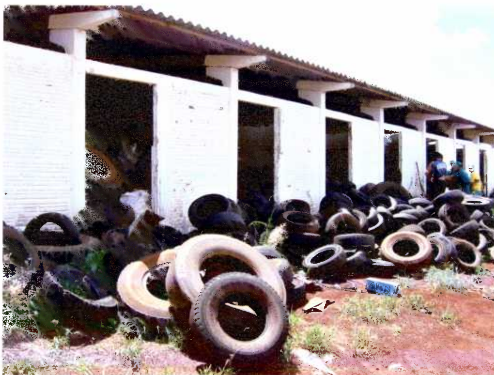
Figura 87 – Vista lateral do galpão de armazenamento temporário de pneumáticos do Município de Toledo-PR, localizado no Parque Tecnológico de Toledo – Tecnoparque.
