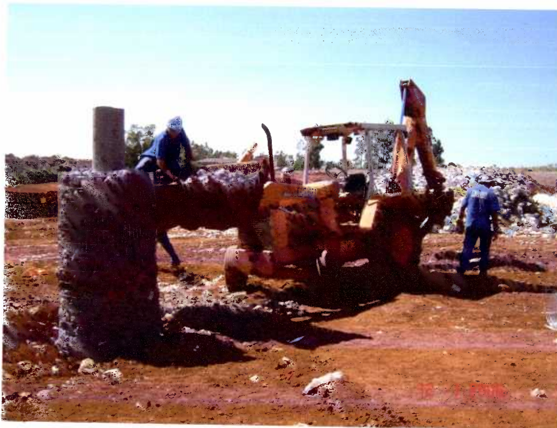
Figura 128 – Construção dos drenos verticais de gases, no aterro sanitário municipal de Toledo-PR.
