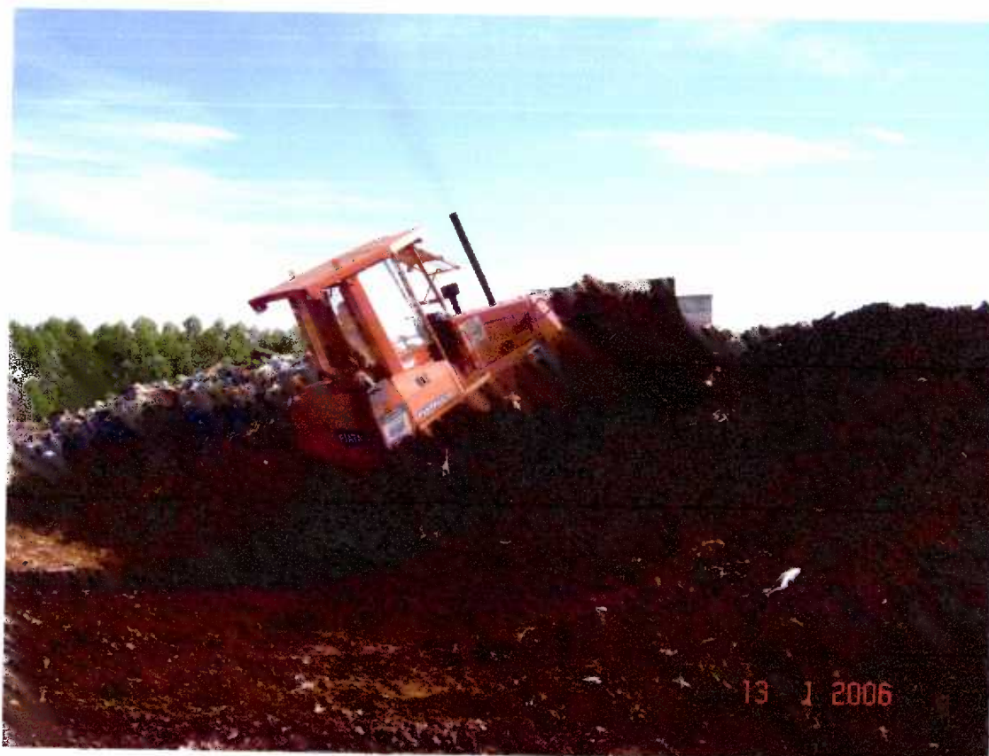
Figura 120 – Cobertura com solo dos resíduos domiciliares no aterro sanitário municipal de Toledo-PR.
