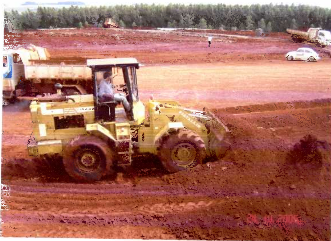
Figura 124 – Equipamentos de apoio no aterro sanitário municipal de Toledo-PR.
