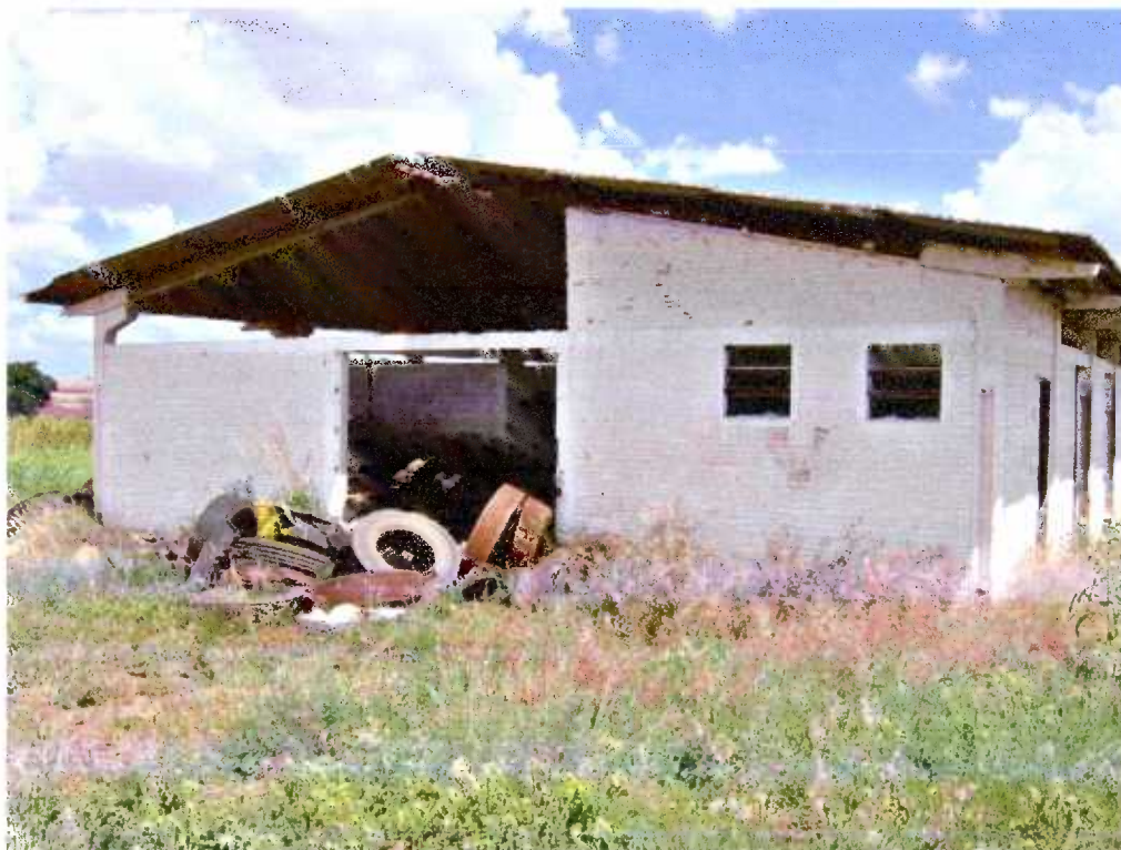
Figura 86 – Galpão de armazenamento temporário de pneumáticos do Município de Toledo-PR, localizado no Parque Tecnológico de Toledo – Tecnoparque.
