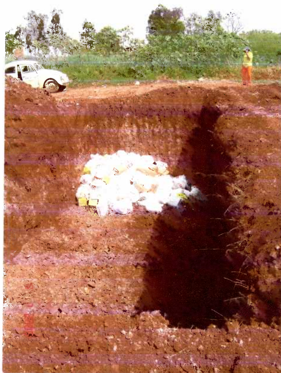
Figura 99 – Vala na qual eram dispostos inadequadamente os Resíduos de Serviços de Saúde - RSS, no aterro sanitário de Toledo-PR.
