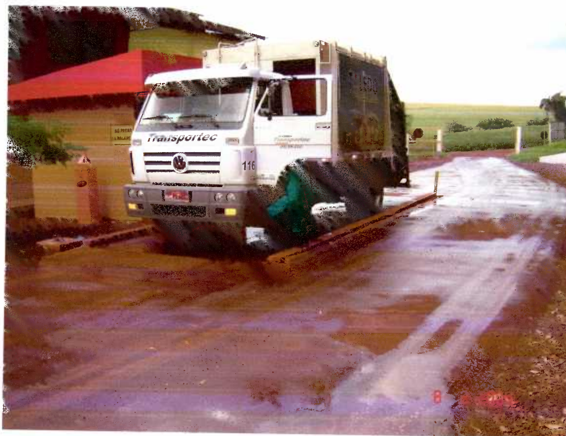
Figura 121 – Balança rodoviária para controle da entrada de resíduos sólidos no aterro sanitário municipal de Toledo-PR.
