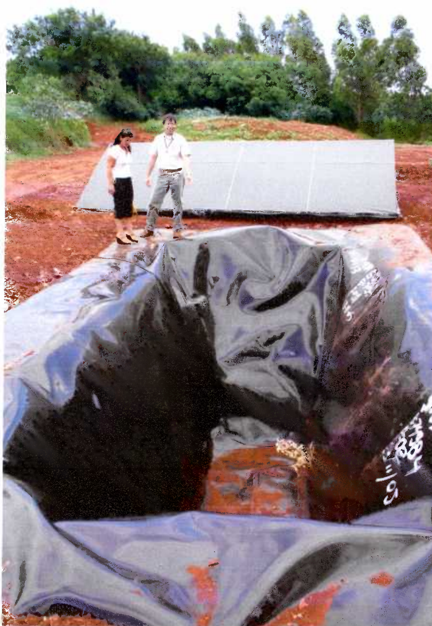
Figura 104 – Conclusão da vala impermeabilizada de RSS, com cobertura móvel, revestida com geomembrana de PEAD 3,0mm, no aterro sanitário de Toledo-PR.
