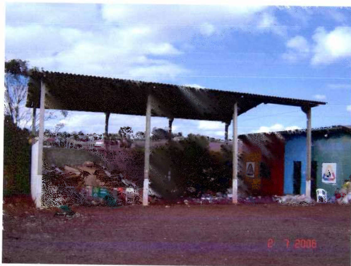
Figura 64 – Galpão de apoio do Ponto Fixo de troca da Av. Maripá, do Município de Toledo.
