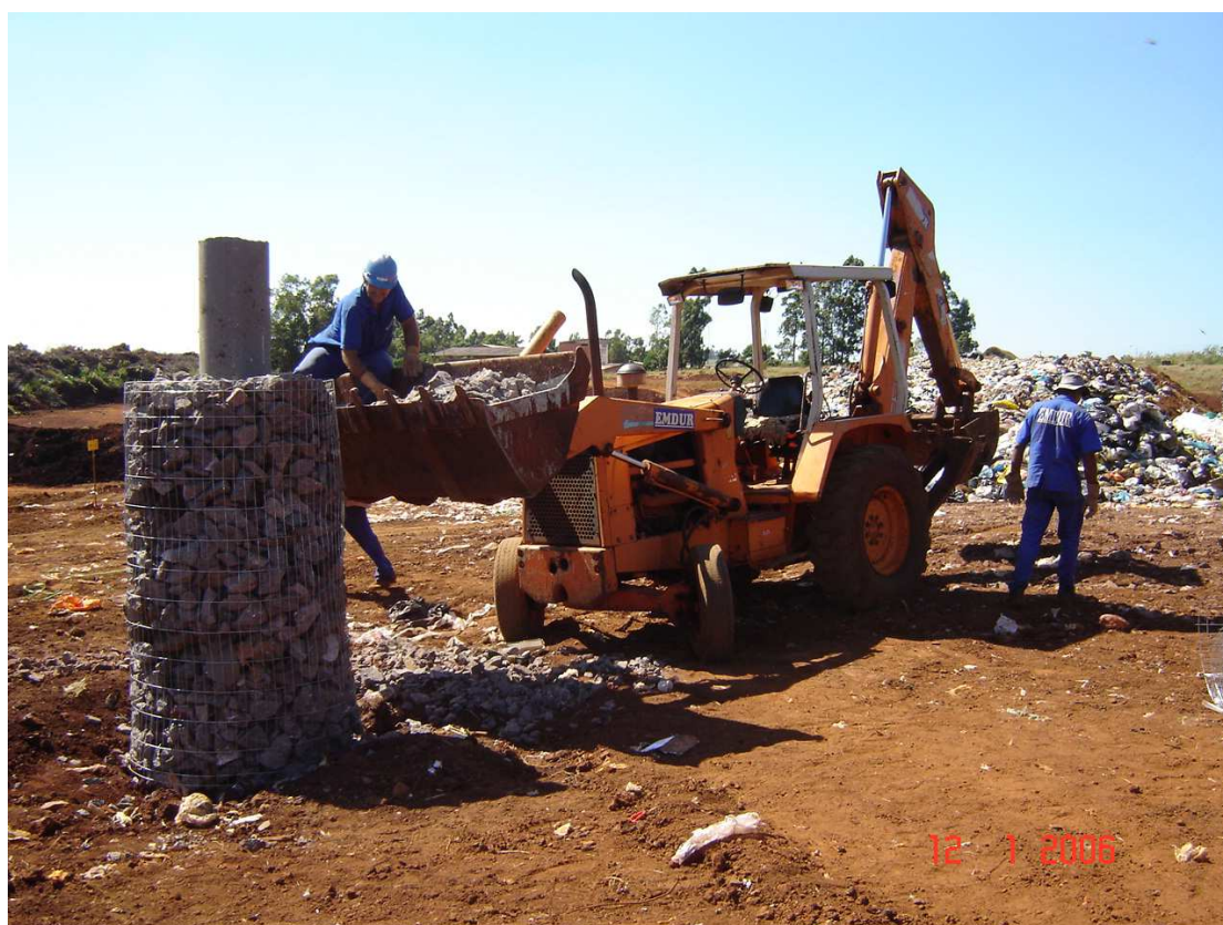
Figura 128 – Construção dos drenos verticais de gases, no aterro sanitário municipal de Toledo-PR.
