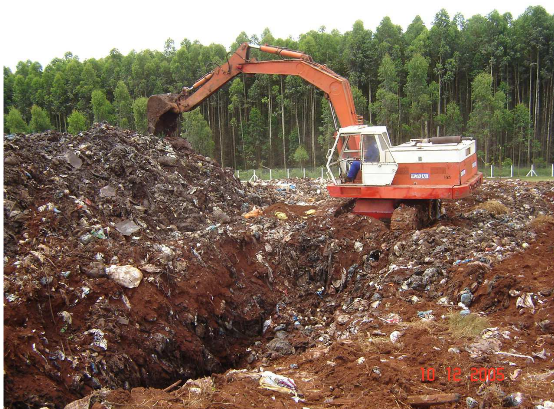
Figura 126 – Obras de recuperação do sistema de drenagem horizontal de chorume, no aterro sanitário municipal de Toledo-PR.
