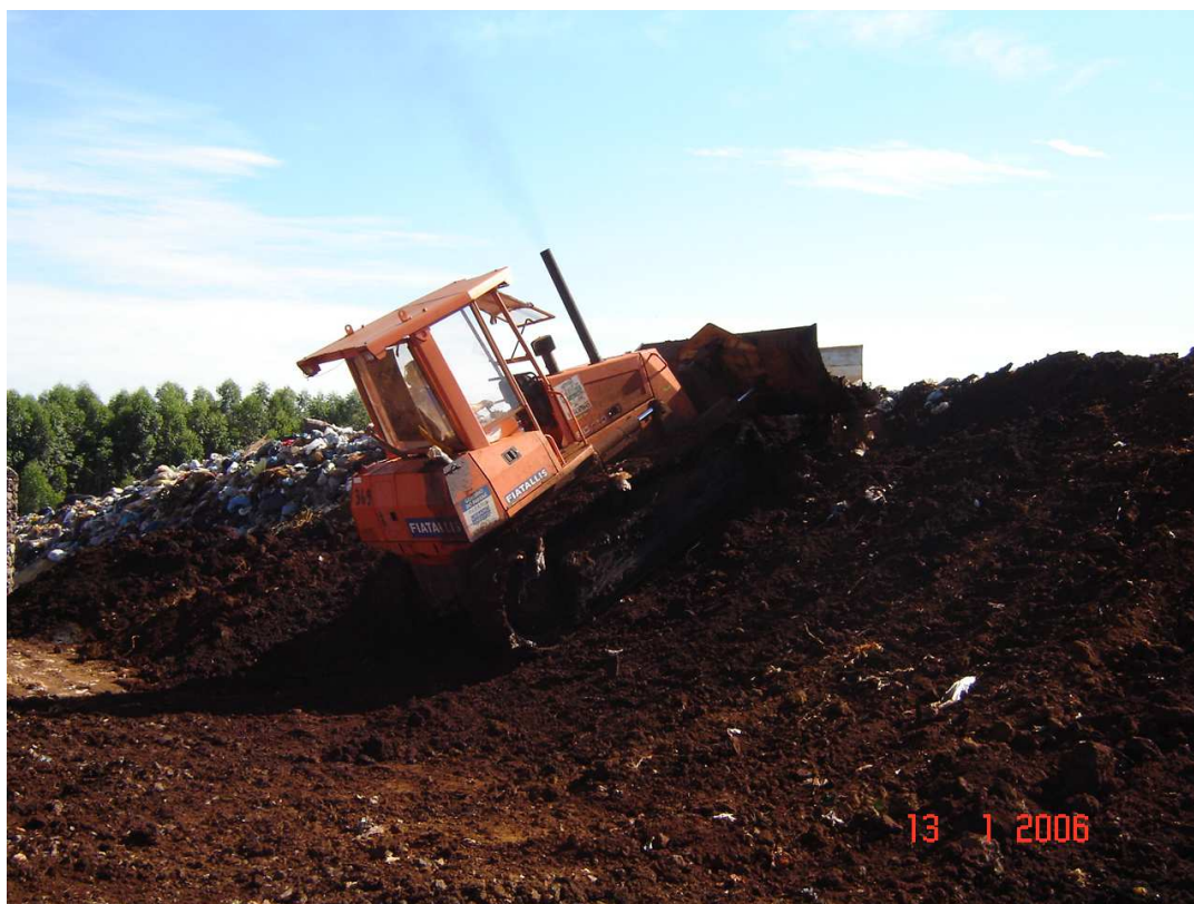
Figura 120 – Cobertura com solo dos resíduos domiciliares no aterro sanitário municipal de Toledo-PR.
