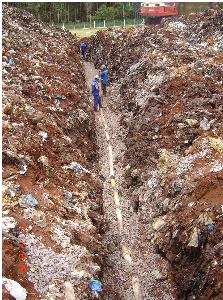
Figura 127 – Recuperação dos drenos horizontais de chorume, no aterro sanitário municipal de Toledo-PR.
