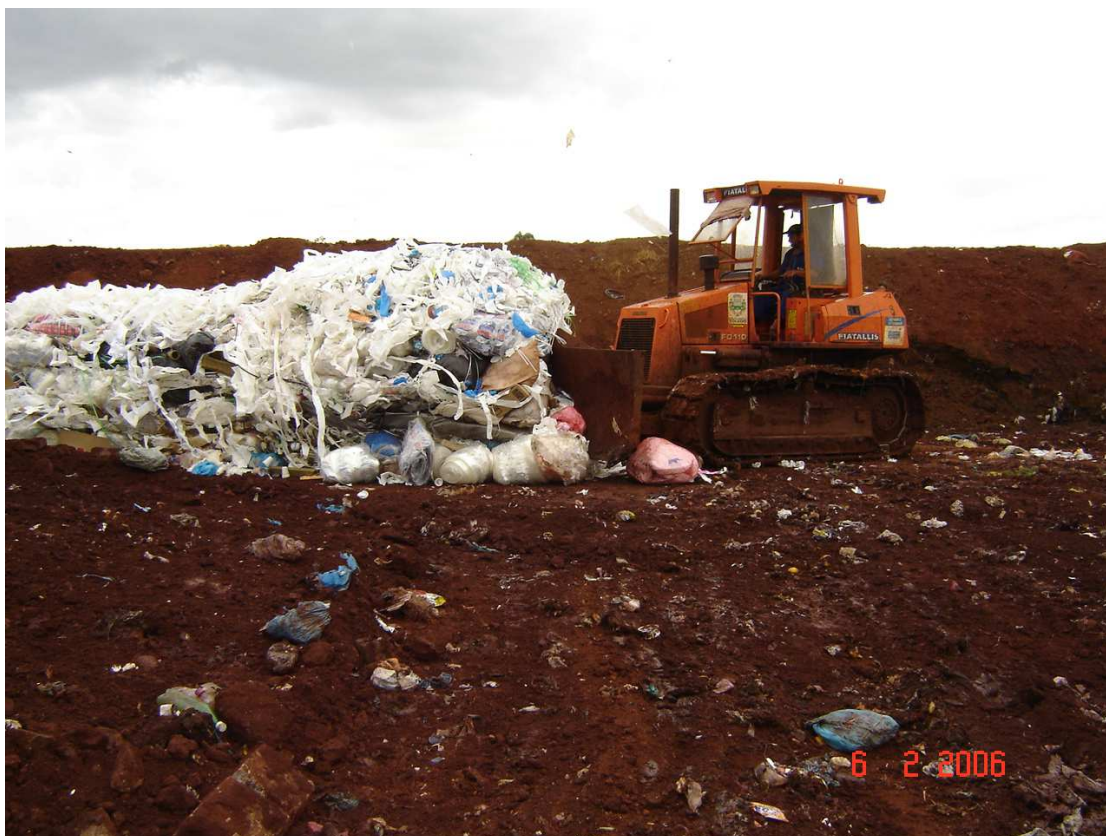
Figura 79 – Compactação dos resíduos industriais no aterro sanitário municipal de Toledo-PR.
