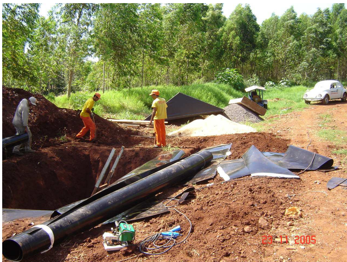
Figura 102 – Construção da vala impermeabilizada para RSS, revestida com geomembrana de PEAD 3,0mm, no aterro sanitário de Toledo-PR.
