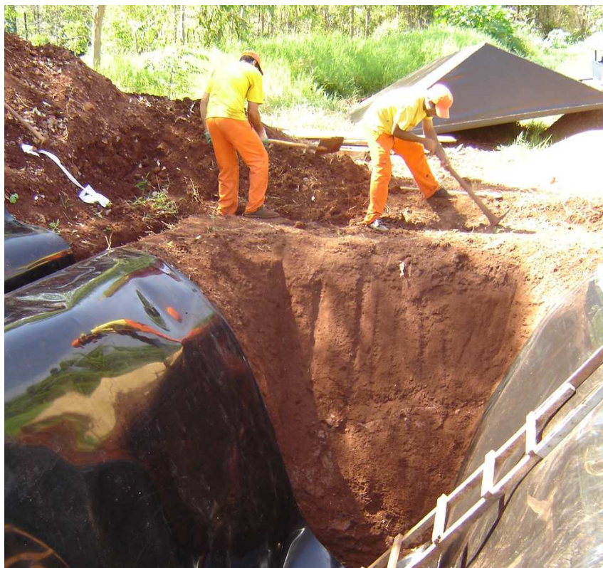
Figura 103 – Construção da vala impermeabilizada para RSS, revestida com geomembrana de PEAD 3,0mm, no aterro sanitário de Toledo-PR.
