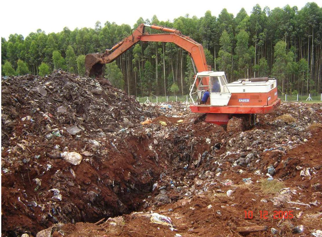
Quando é detectado algum problema no sistema de drenagem de águas pluviais, percolados e gases, realiza-se uma intervenção emergencial para a resolução do problema.
