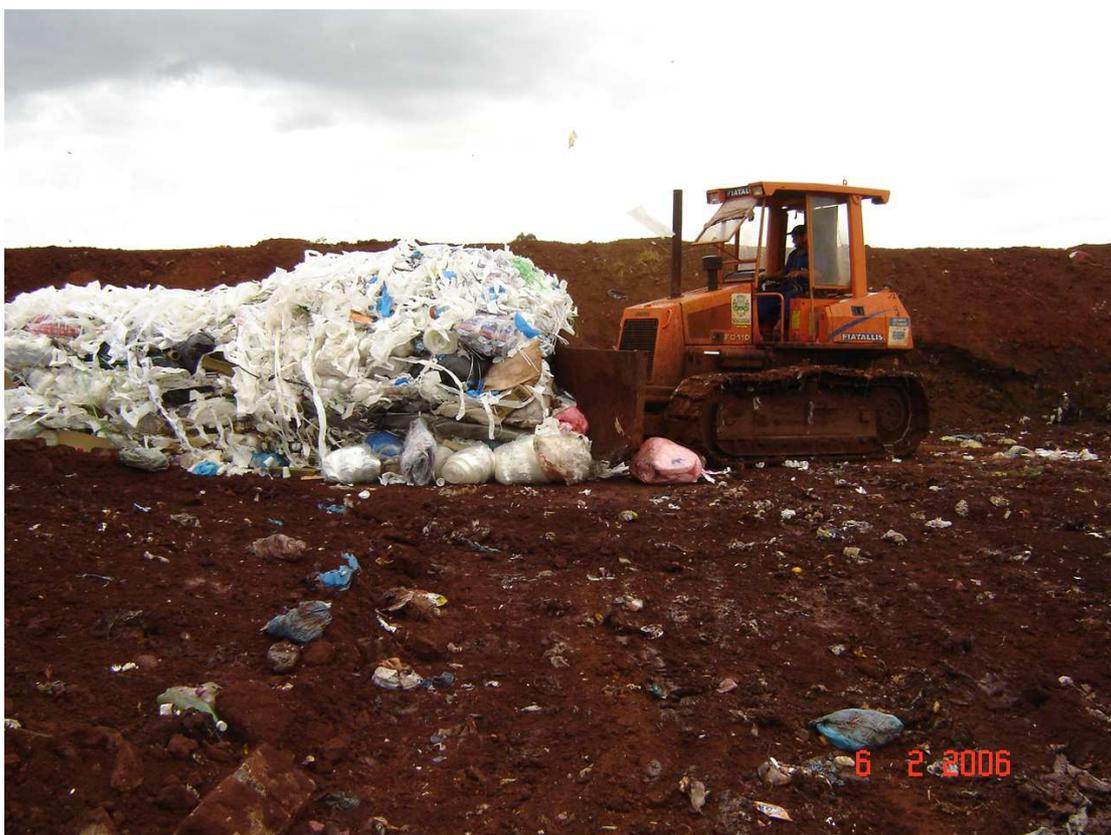
Figura 90 – Disposição de resíduos industriais (Classe II-A e II-B) compatíveis com o resíduo domiciliar, no aterro sanitário municipal de Toledo-PR.
