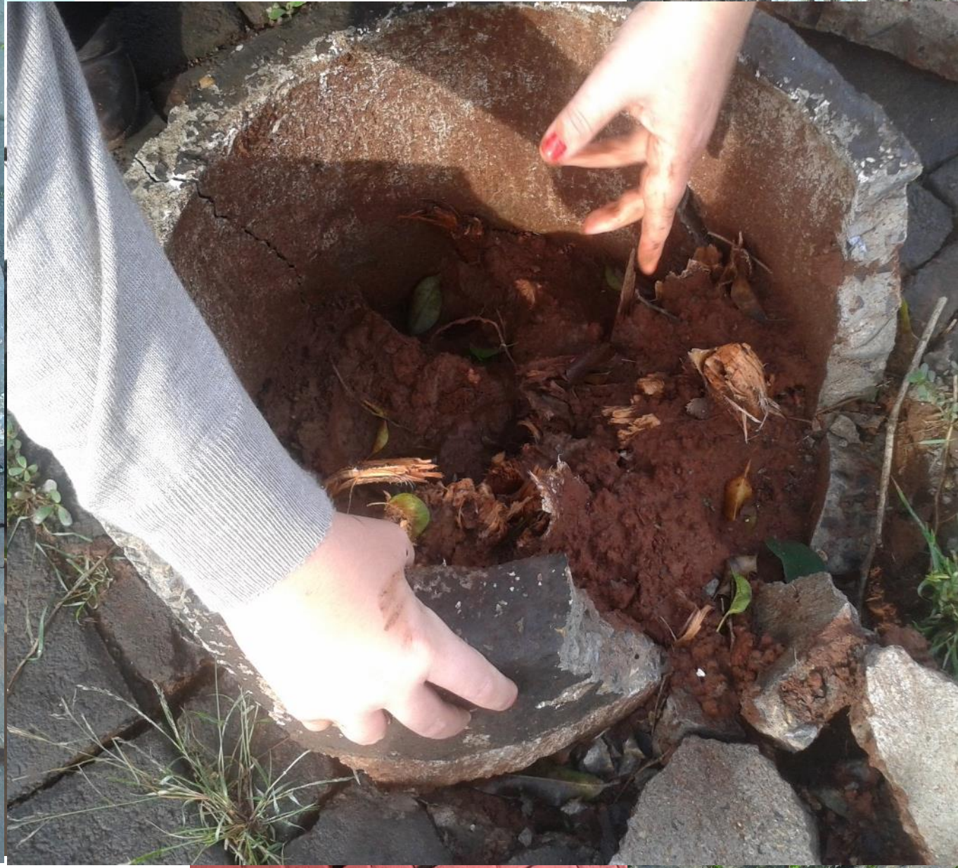
Figura 6: Situações de enovelamento de raízes, ruptura de manilha por Ficus ( Ficus benjamina ) em via pública de Dois Vizinhos – PR, Brasil.
