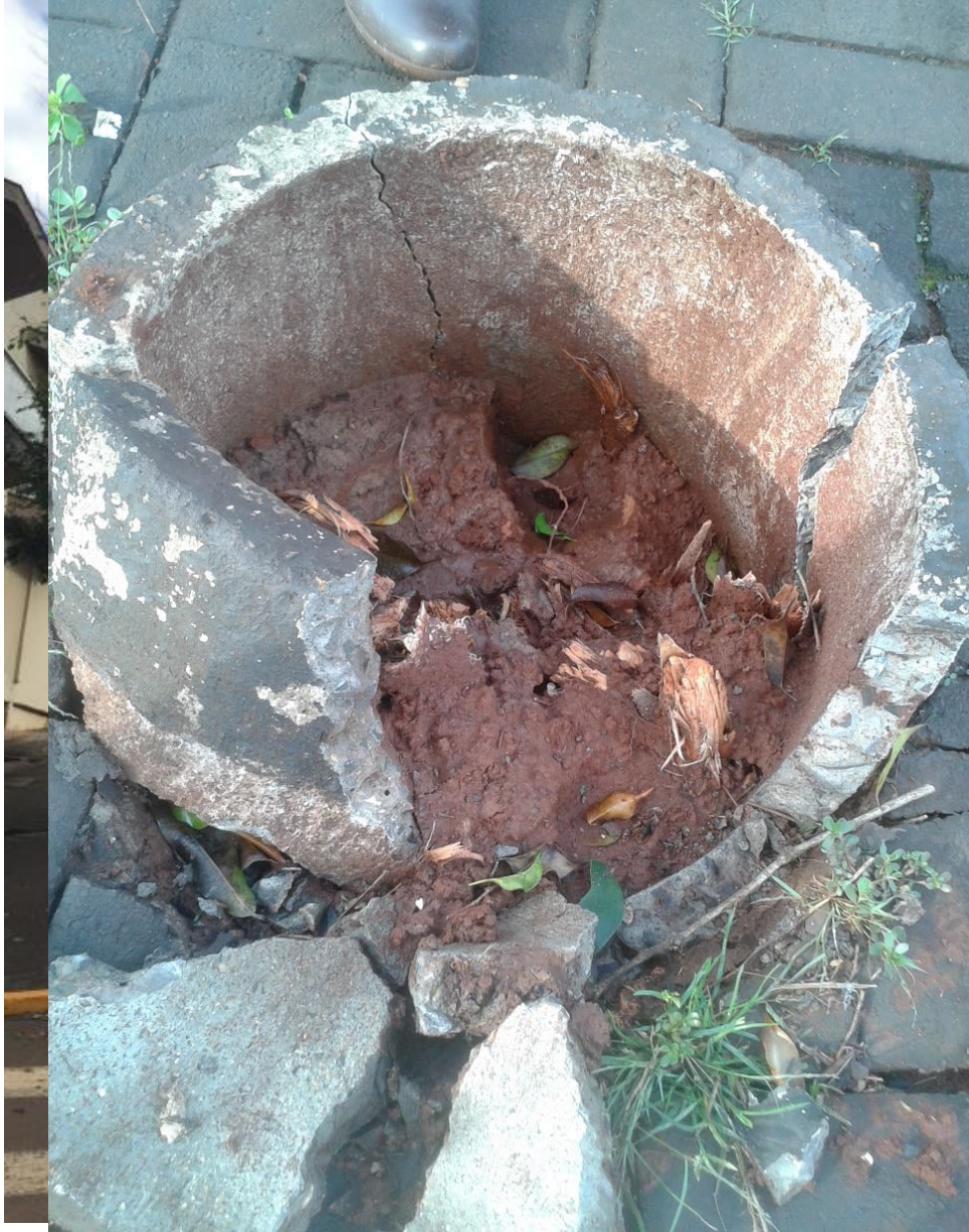
Figura 6: Situações de enovelamento de raízes, ruptura de manilha por Ficus ( Ficus benjamina ) em via pública de Dois Vizinhos – PR, Brasil.
