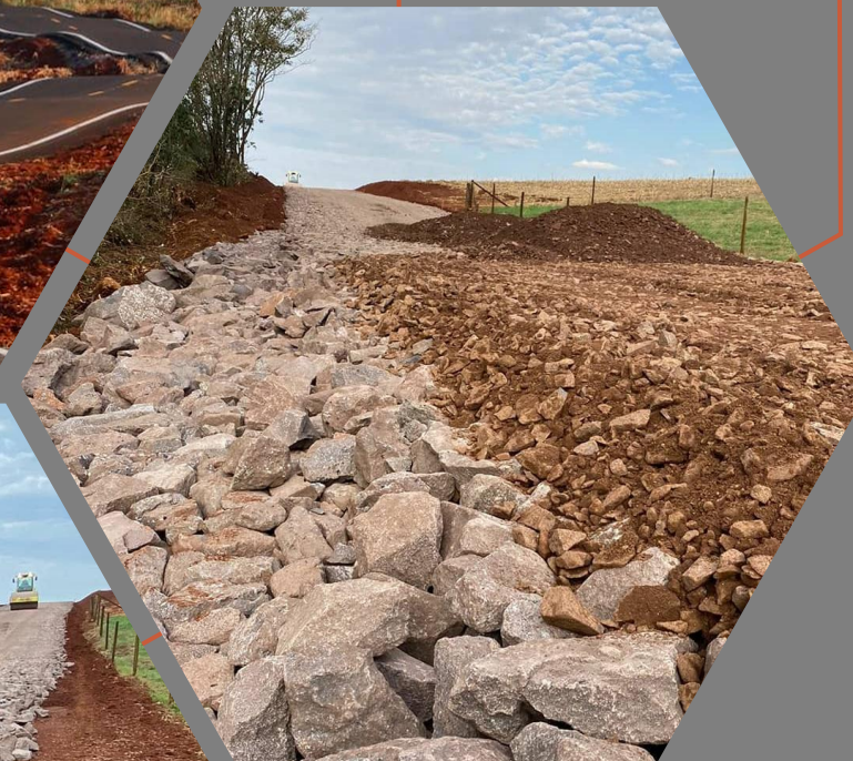
Imagem 2: Sub-base de rachão em Novo Sobradinho
