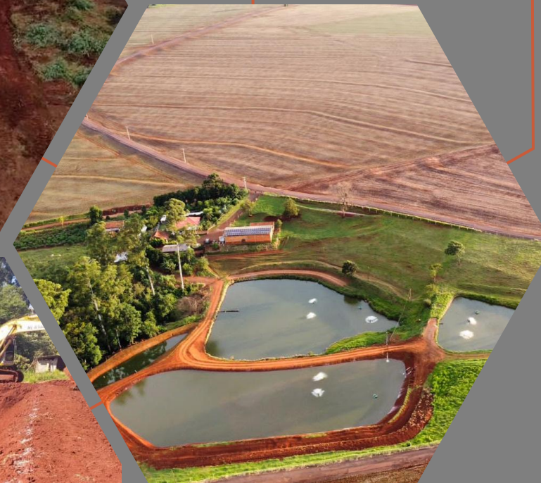
Imagem 2: Escavação para açude.
