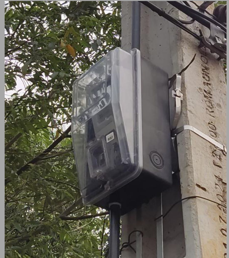
Figura: Caixa de medição com a tampa de acrílico substituída por uma nova
