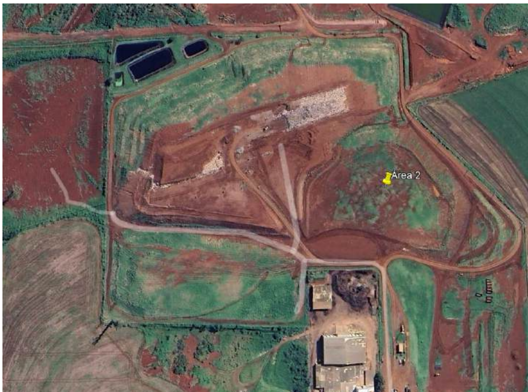
Figura 15 – Indicação da Área 2 a ser utilizada para destinação final dos resíduos volumosos.
