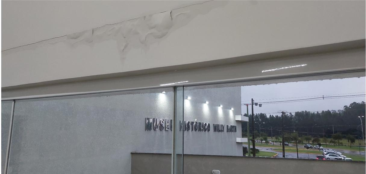
Figura 16 – Infiltração e danos na parede da sacada no segundo pavimento.
