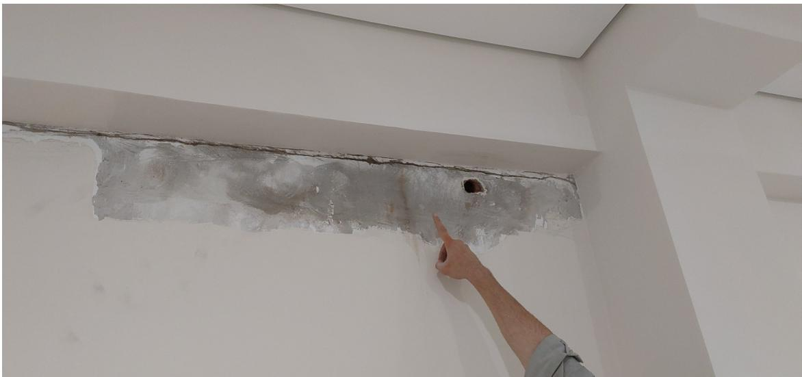
Figura 14 – Apontamentos dos danos da chuva na sala de exposição permanente.
