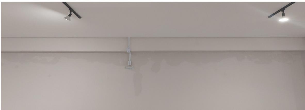
Figura 15 – Infiltrações na exposição de longa duração após chuva forte.
