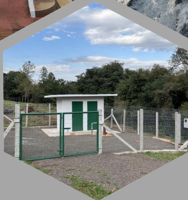
ABASTECIMENTO DE ÁGUA NA LINHA MANDARINA
