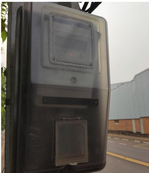
**Figura: Caixa de medição com a tampa de acrílico substituída por uma nova**
